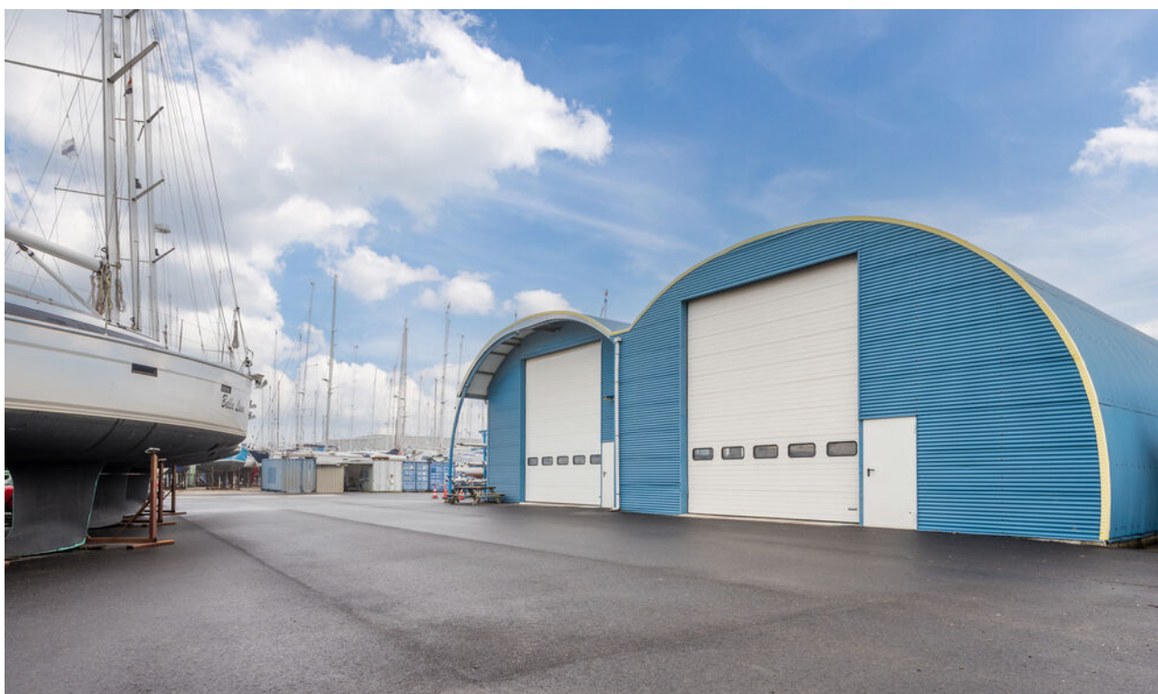
Werkplaats, winterstallingsloodsen en botenwagen
